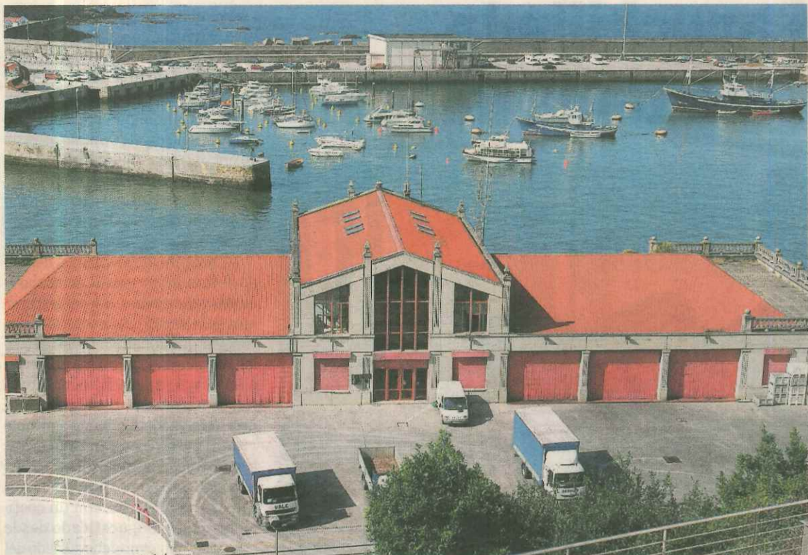
TRANSFORMACIÓN. Vista exterior de la actual lonja de pescado de Bermeo. / M. SALGUERO
